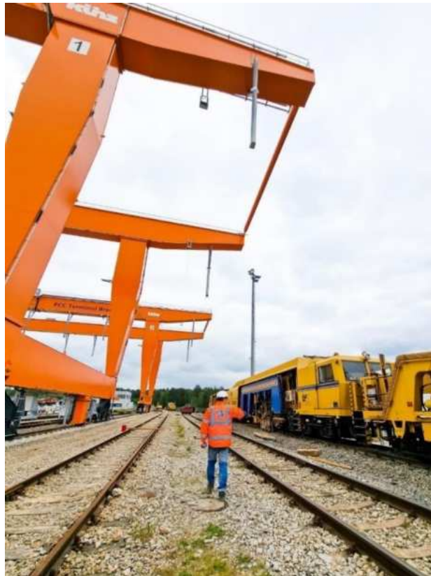
Foto 33. Terminal ppcc en Brzeg Dolny – Polonia
