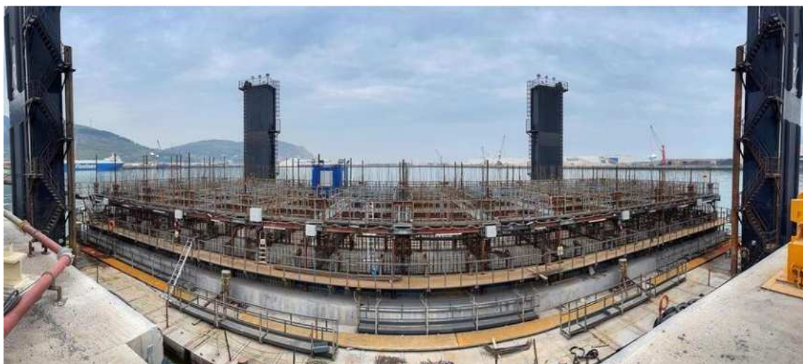
Foto 03 - 04. Prolongación muelle AZ1. Puerto de Bilbao.
