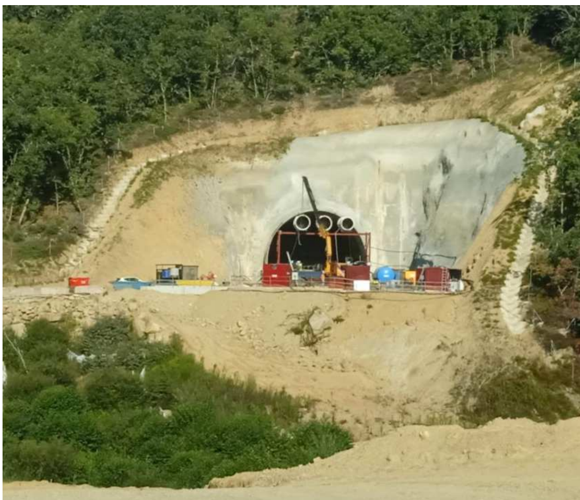
Foto 06. Túnel de Rante.
