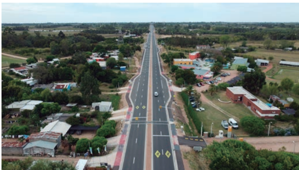
Finalización del tramo
