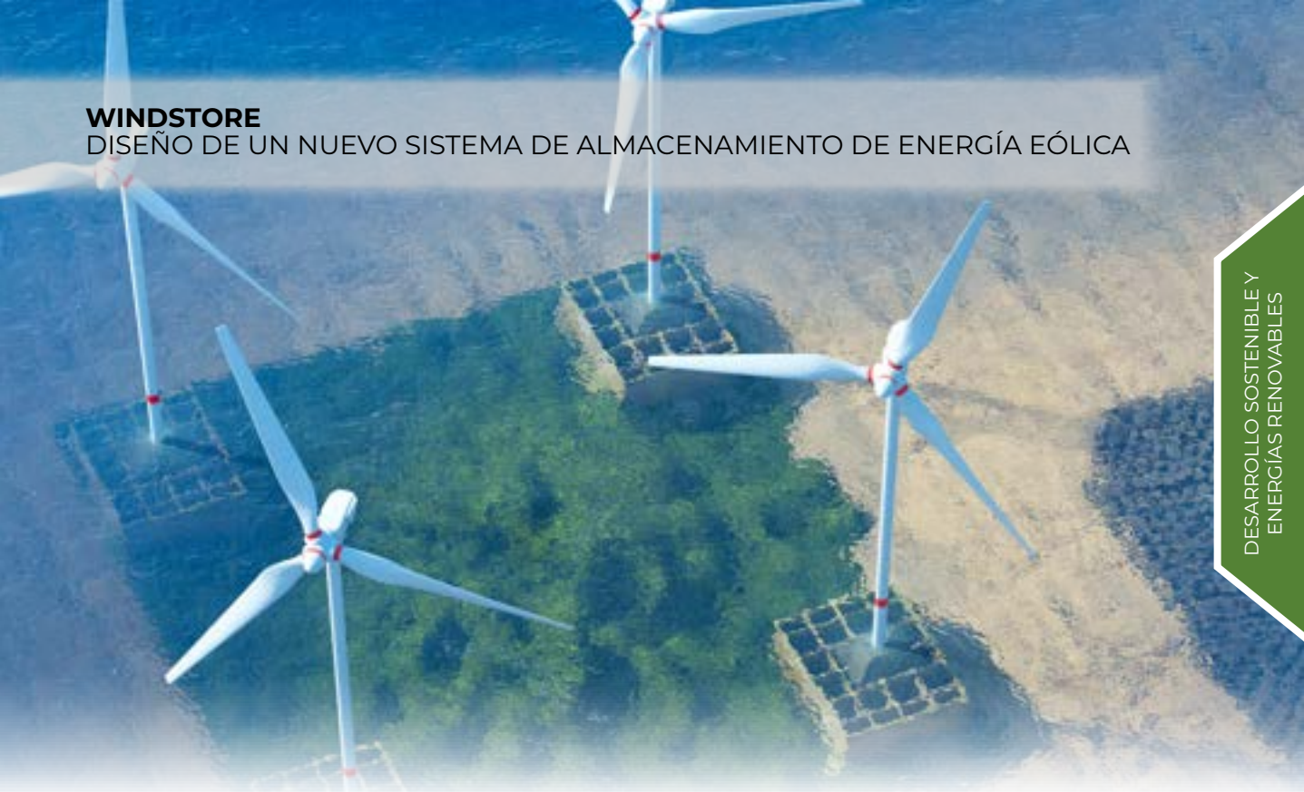
Representación de un parque eólico portuario basado en la tecnología de cajones de gravedad
