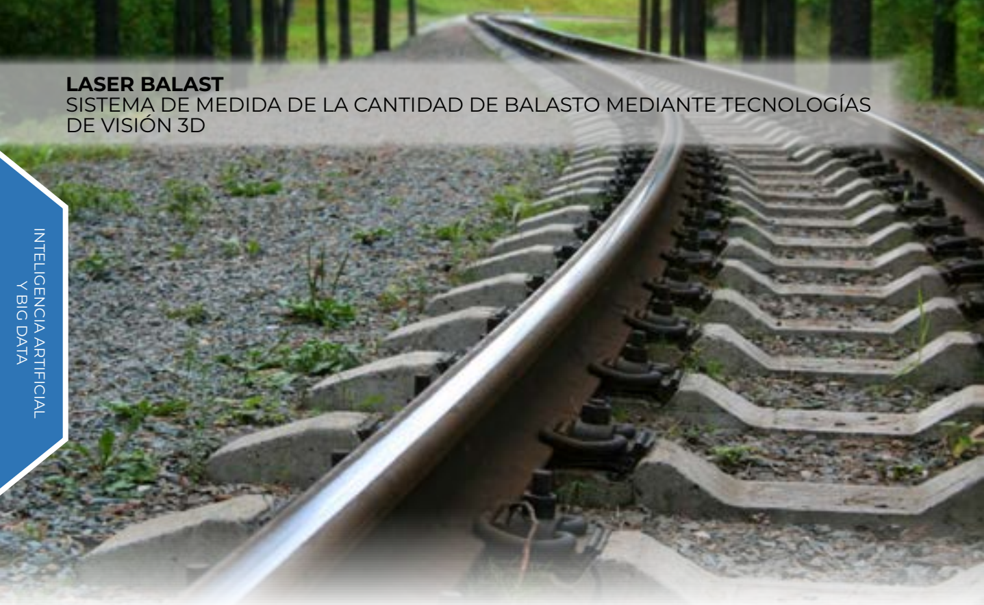
Imagen de un tramo de vía
