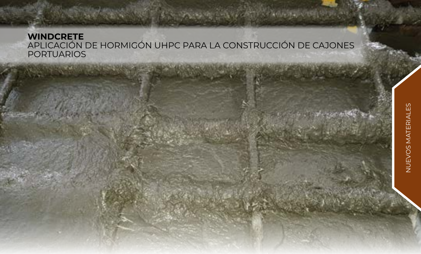
Ejecución de prueba piloto con el hormigón diseñado
