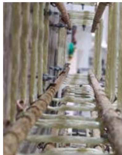
Armadura preparada para hormigonar las vigas piloto del proyecto
