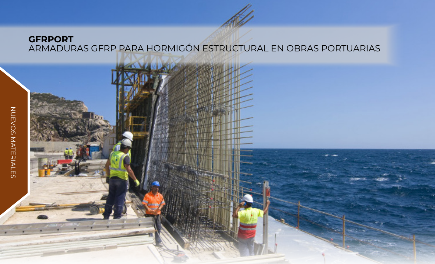
Obra de Rover en el Puerto de Cartagena. Ejecución de un espaldón con armadura de fibra de vidrio
