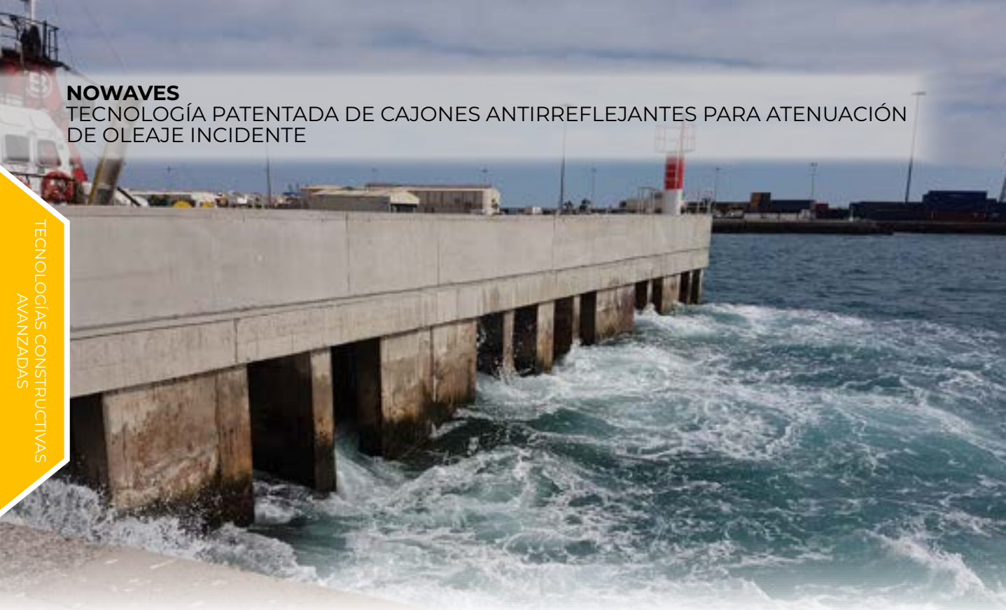
Piloto real de la tecnología NoWaves en funcionamiento ejecutado en el Puerto del Rosario
