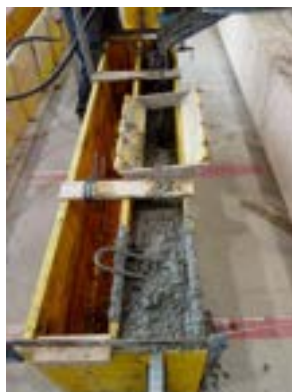
Ejecución del prototipo a ensayar
